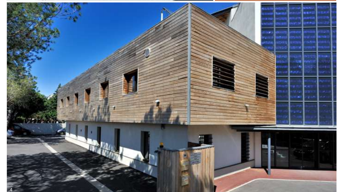
1. Raboté abouté, Saint-Louis / 2. Raboté, profil sur-mesure / 3. Brut de sciage, Channel Sidding / 4. Raboté, Saint-Louis
