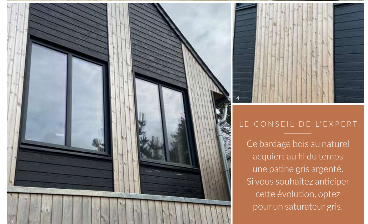
1 et 2. Bardage juste posé / 3 et 4. Bardage 1 an après la pose
