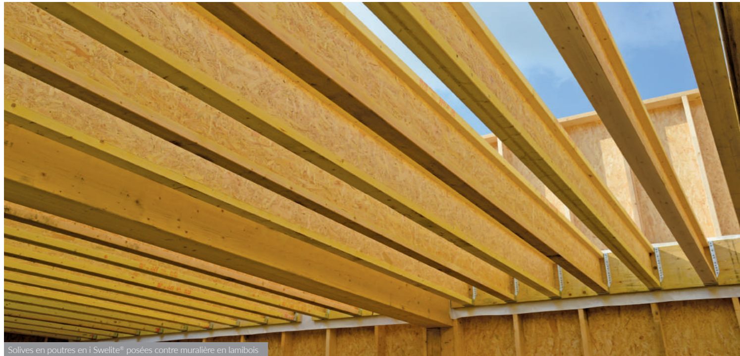
Solives en poutres en i Swelite® posées contre muralière en lamibois
