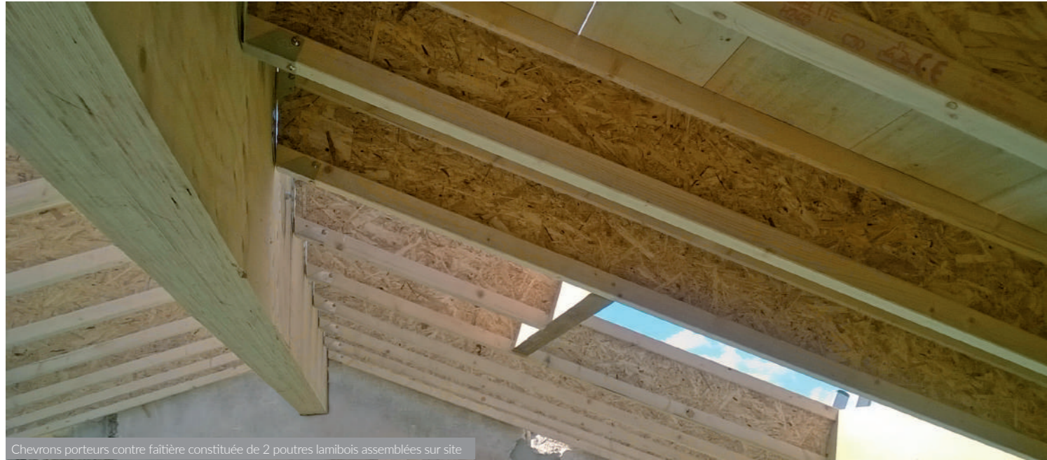
Chevrons porteurs contre faîtière constituée de 2 poutres lamibois assemblées sur site
