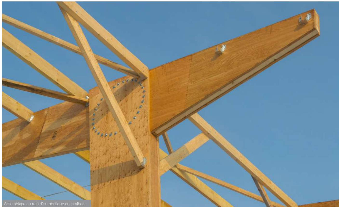
Assemblage au rein d'un portique en lamibois
