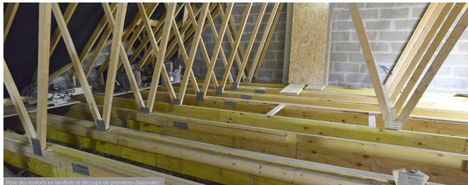
Pose des renforts en lamibois et découpe de premières diagonales
