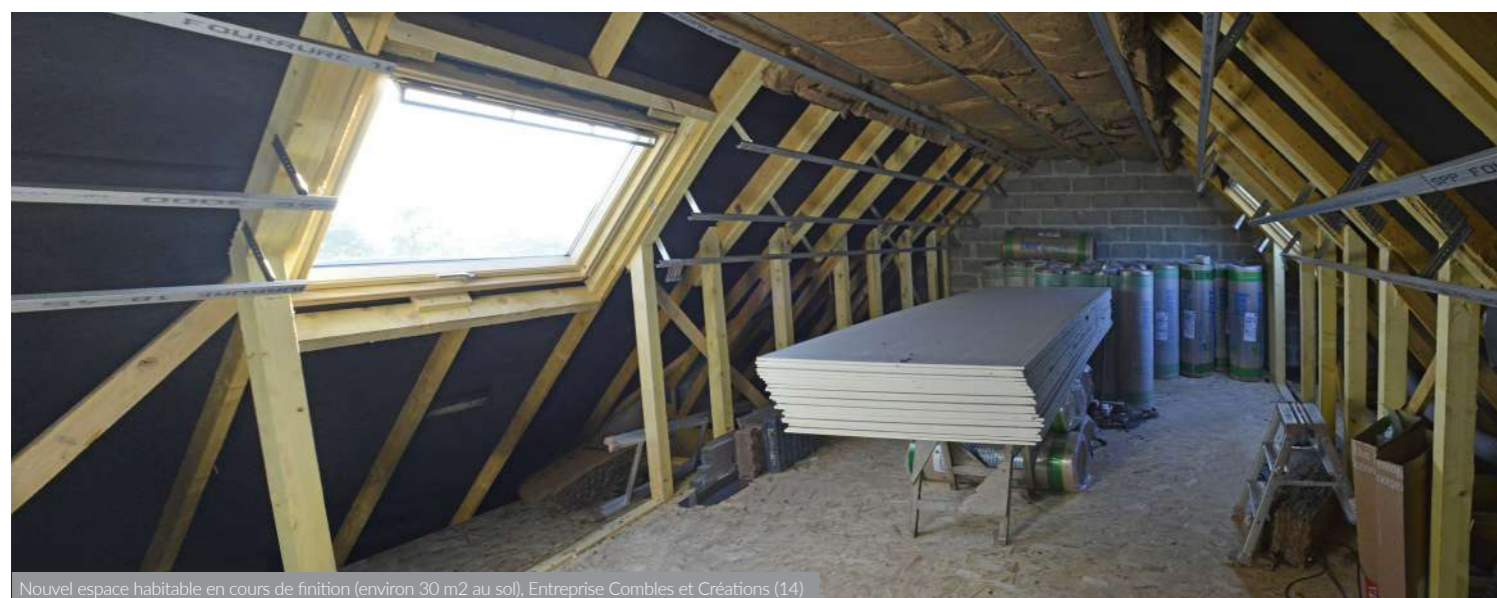
Nouvel espace habitable en cours de finition (environ 30 m 2 au sol), Entreprise Combles et Créations (14)
