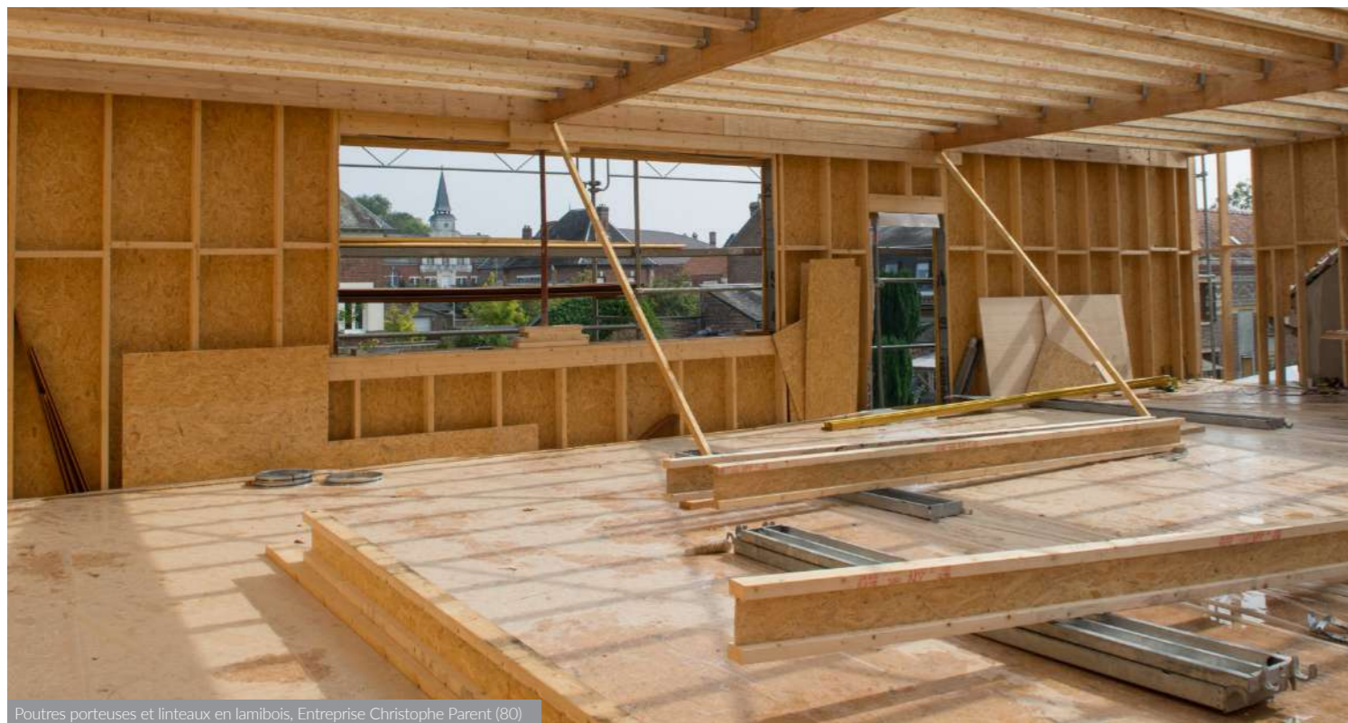
Poutres porteuses et linteaux en lamibois, Entreprise Christophe Parent (80)
