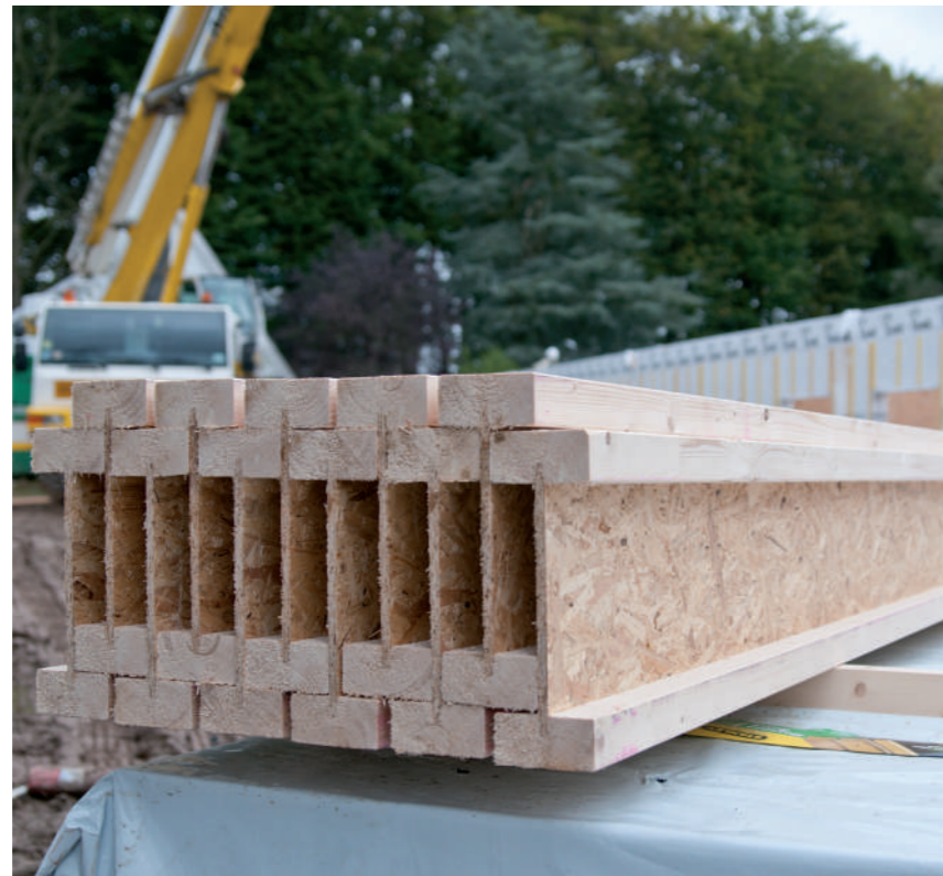
Poutres en i en cours d'approvisionnement. Elles sont stockées sur chant. Les bâches de protection contre les intempéries sont ôtées au fur et à mesure des besoins.
