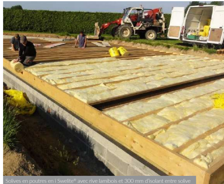
Solives en poutres en i Swelite® avec rive lamibois et 300 mm d'isolant entre solive
