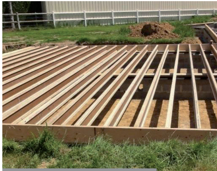
Solives en poutres en i Swelite® contre ceinture porteuse en lamibois
