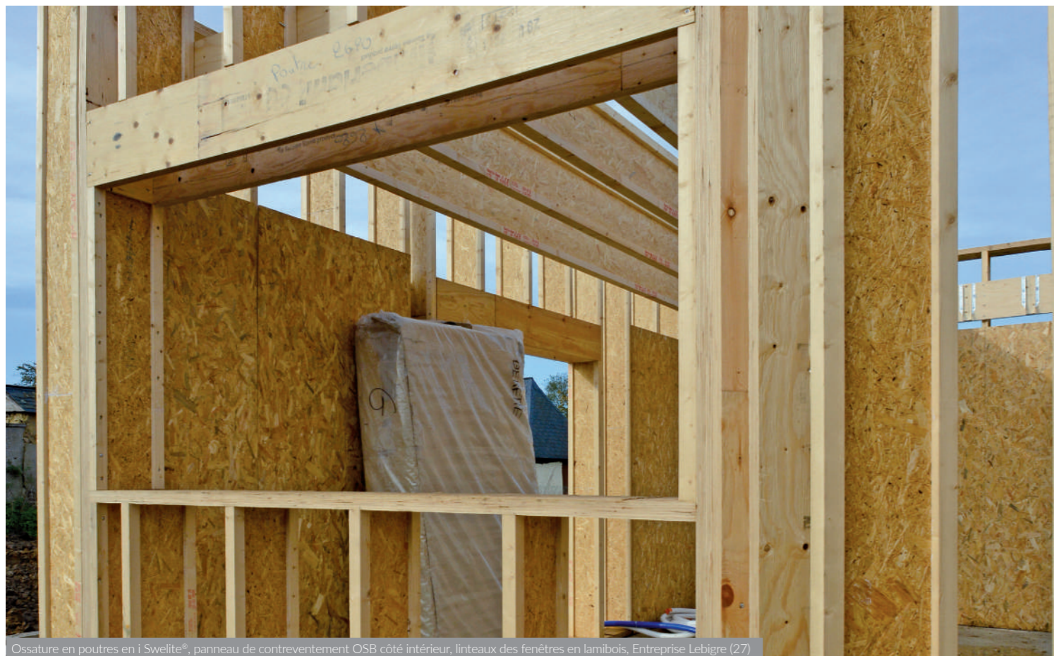
Ossature en poutres en I Swelite®, panneau de contreventement OSB côté intérieur, linteaux des fenêtres en lamibois, Entreprise Lebigre (27)
